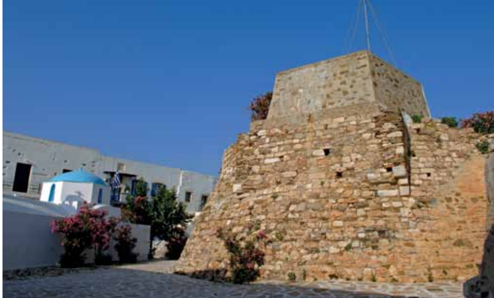
136. Das Fundament des Turmes in der Mitte der venezianischen Burg.
