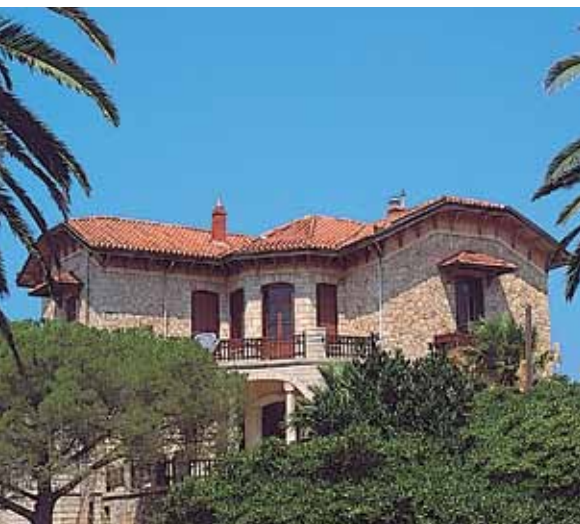
99. Typisches Landhaus in Poseidonia, in welchem das Rathaus der Region beherbergt ist.
