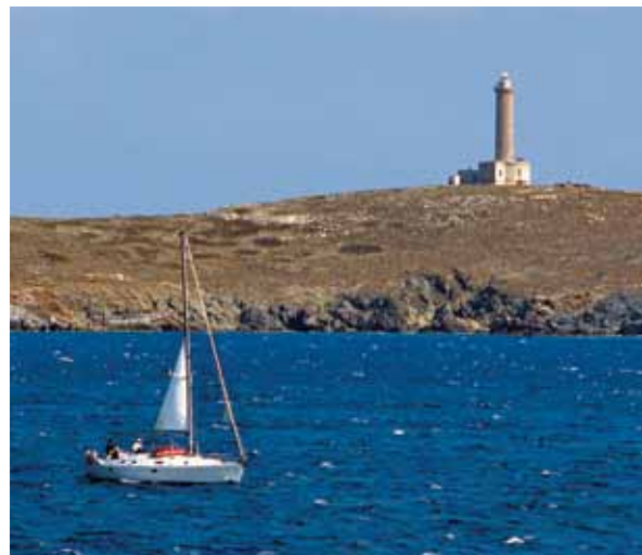
95. Der steinerne Leuchtturm des Gaidouronisi Eilands, außerhalb des Hafens von Ermoupolis, ist der älteste (1834) und höchste (29 m) aller Leuchttürme Griechenlands.
