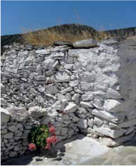
223. Typische Trockensteinmauern in Chora.
