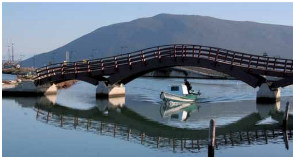
29. Die charakteristische Brücke am Kanal von Lefkada-Stadt.
